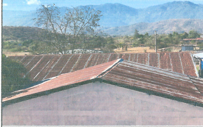
Foto 1: Mejoramiento de techo de lamina troquelada No. 26 y mantenimienton de estructura constante metalica.
